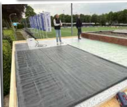
Michiel Bakker en Giel Baan isoleren het dak
