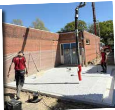
De mannen van Ruiter Bouw storten beton
