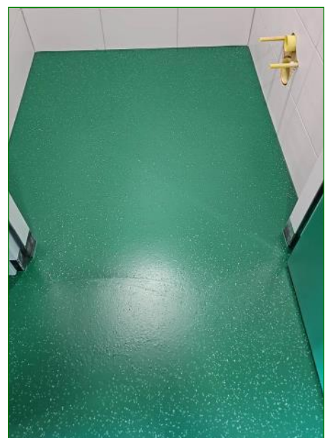
Gietvloer nieuwe toiletten
