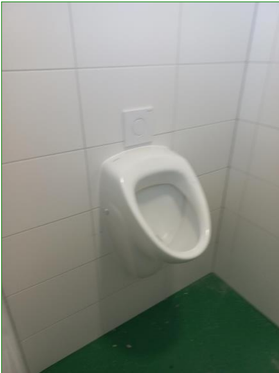
Afbouw toiletten kleedkamers 1-6
