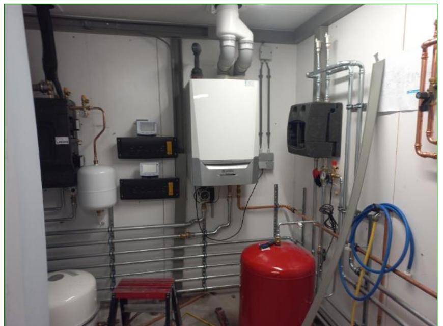
Nieuwe technische ruimte
