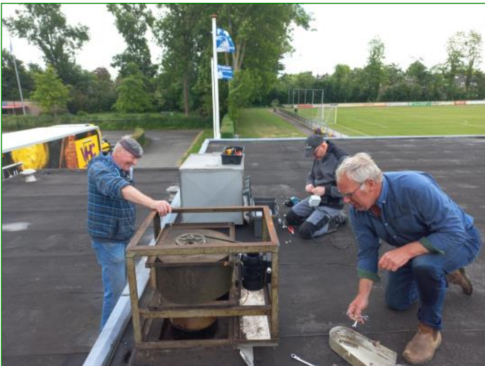
Reparatie afzuiginstallatie kantine
