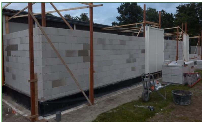
Aanzicht binnenmuren lijmwerk kalkzandsteenblokken
