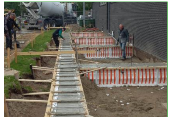
Betonwerk funderingsbalken
