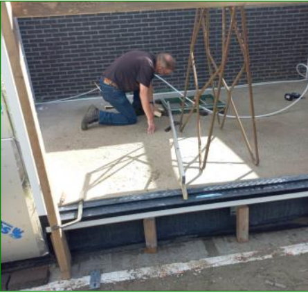
Vloerluiken plaatsen in berging.
