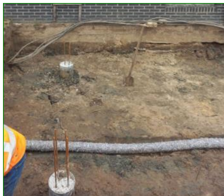
Grondwerk voor de fundering
