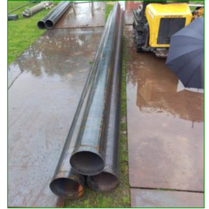
Aanzicht buispalen diameter 218 mm lang 13 m1
