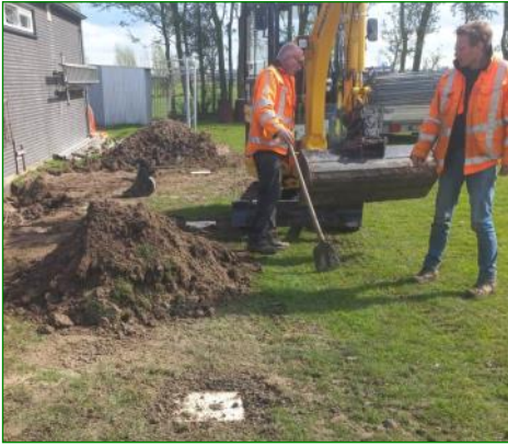
Uitzetwerk buispalen 10 stuks voor heiwerk fundering
