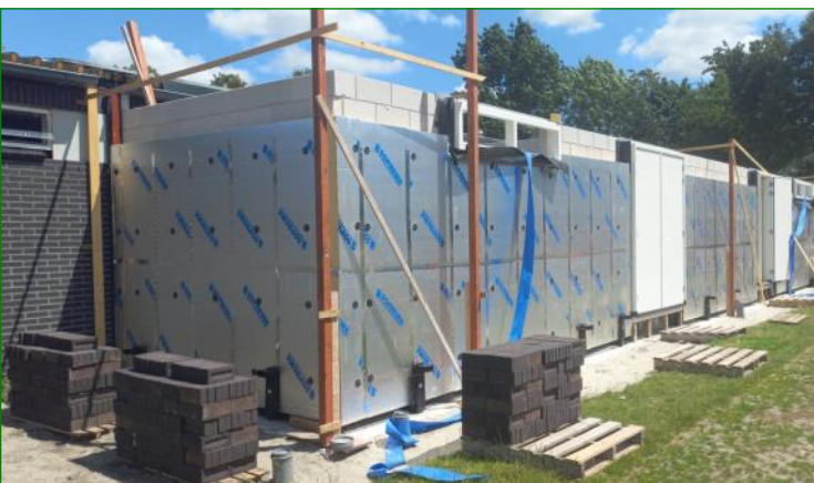
Aanzicht isolatieplaten tegen binnenblad
