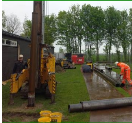
Heiwerk buispalen 13 m1 lang
