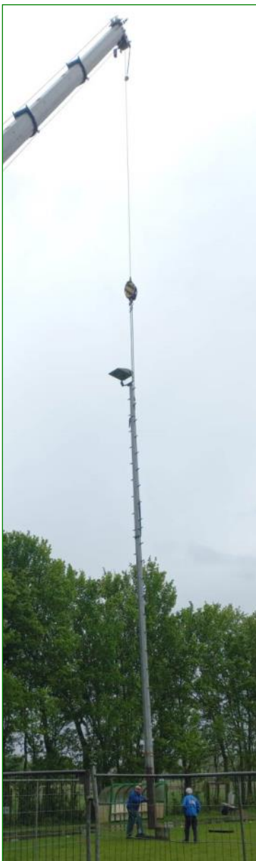
Lichtmast verplaatsen i.v.m. maken van de fundering
