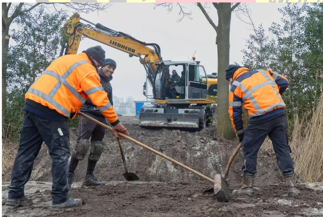
Drukke werkzaamheden bij onze voormalige trainingshoek
