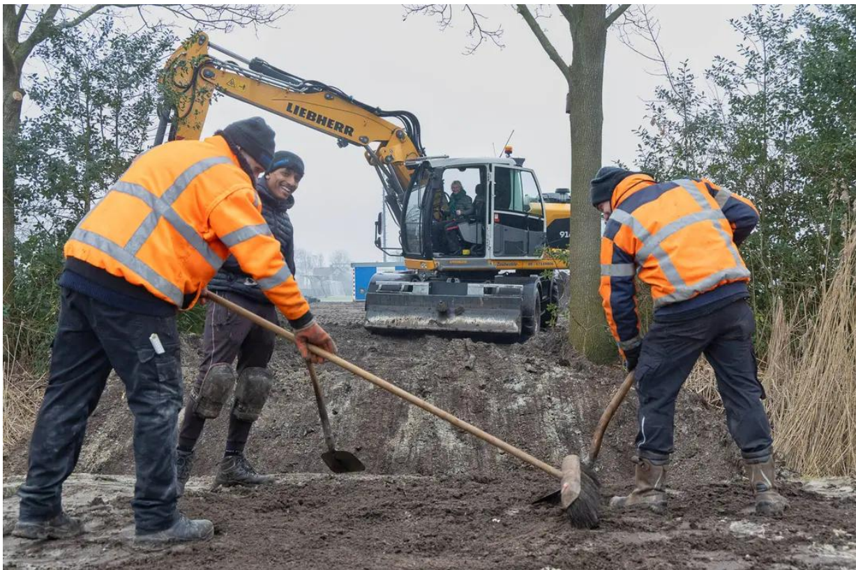
Figuur 4: Wethouder Hempen geeft het startsein voor de bouw
