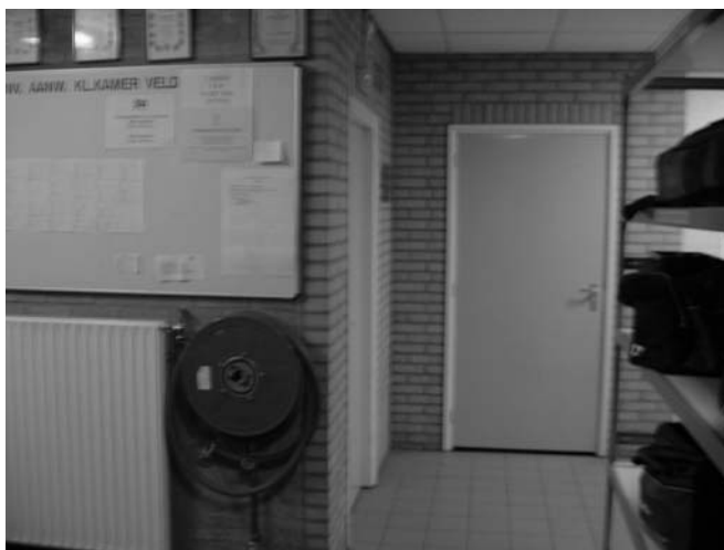
De plek waar de nieuwe toiletten gerealiseerd zullen worden.
