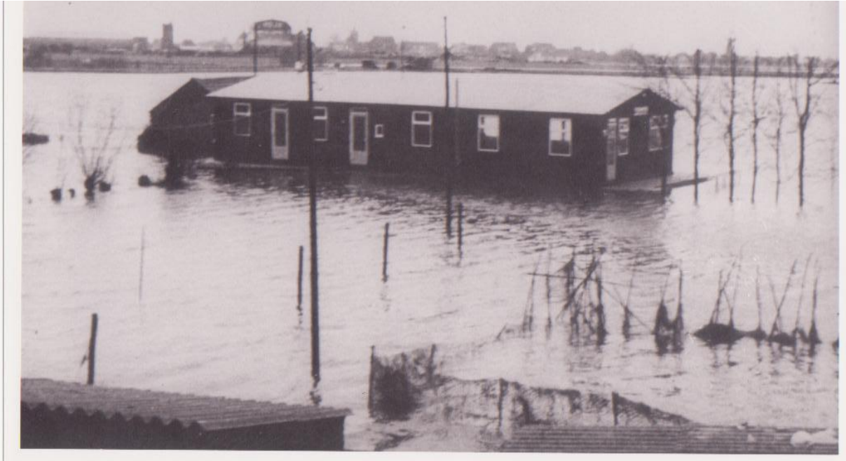
Hoog water, daarna de kantine in de carboleum zetten.
