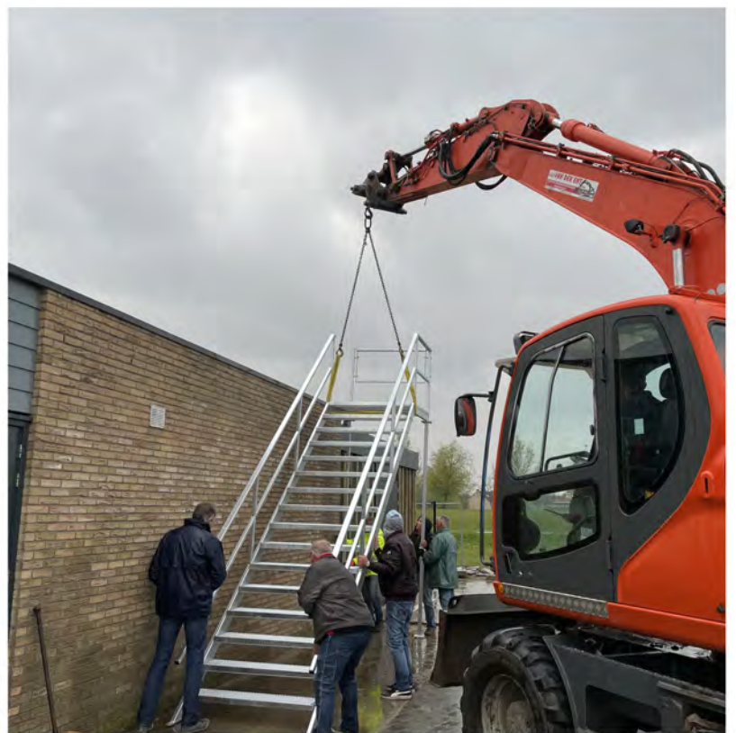
Mijlpaal 29 april! Plaatsen en monteren van de trap naar het dakterras voor het sponsorhome, bestuurskamer en vergaderruimte.
