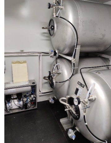
Geen gezeul meer met fusten door installatie nieuwe biertanks
