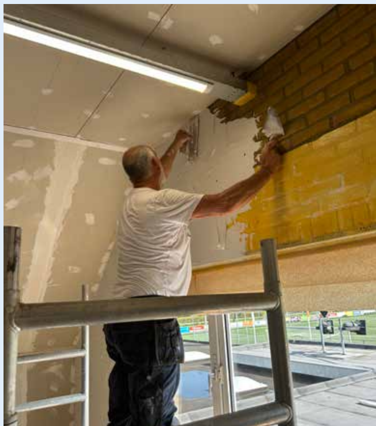
Onder deskundige leiding van Kees Lamens vindt de verbouwing plaats.
