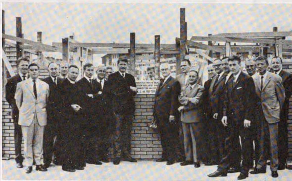
De eerste steenlegging door A.B.J. de Ruyter op 21 augustus voor het Clubgebouw op het sportpark Ookmeer.
