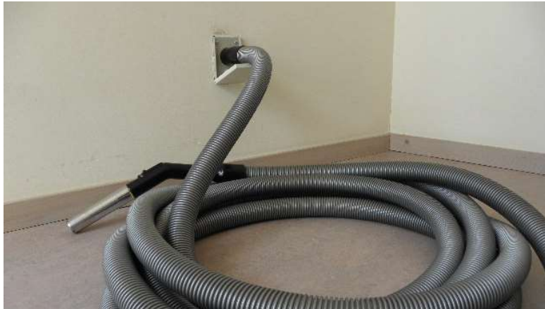
Centraal stofzuigersysteem in de Pieter Wijtenschool te Waalwijk. Het vermindert allergieklachten en geeft geen stof turbulentie in de lokalen.
