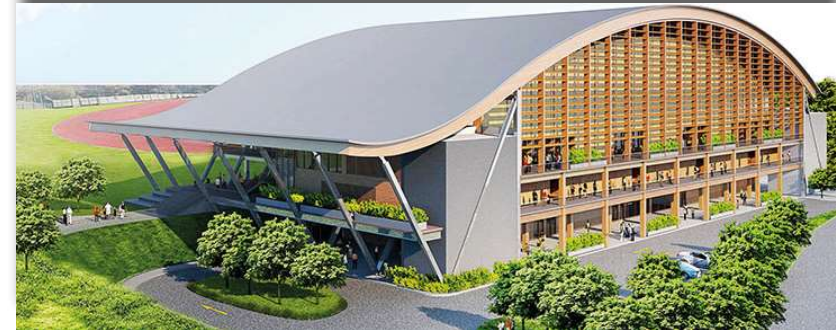
Sporthal van de Nanyang Technological University is gerealiseerd als proeftuin voor duurzame initiatieven om een energiezuinig gebouw te bouwen. Onder andere een bijzondere houten dakstructuur, dat beter isoleert dan beton, zorgt voor een 40% lager energieverbruik.
