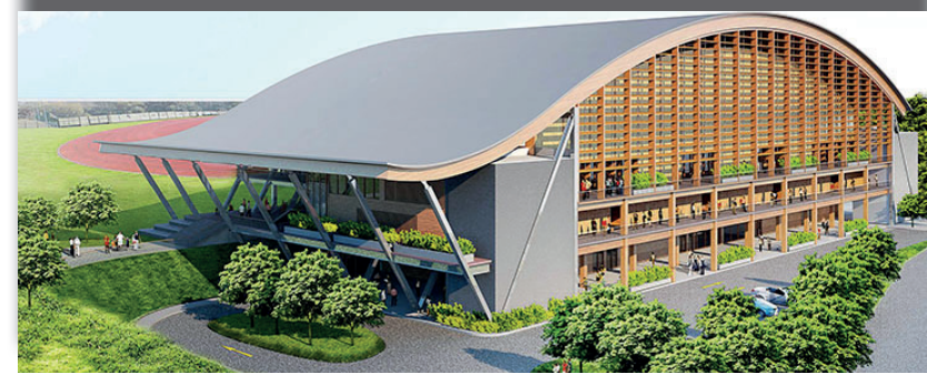
Sporthal van de Nanyang Technological University is gerealiseerd als proeftuin voor duurzame initiatieven om een energiezuinig gebouw te bouwen. Onder andere een bijzondere houten dakstructuur, dat beter isoleert dan beton, zorgt voor een 40% lager energieverbruik.
