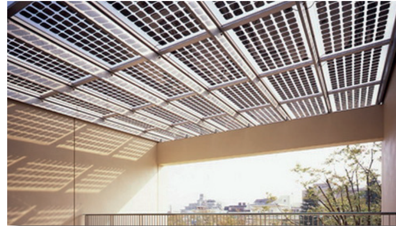
Zonnecellen in ramen; licht, schaduw, minder warm en elektriciteit in een systeem.
