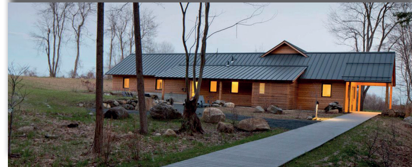
Het Smith College te Bechtel is gebouwd volgens het 'Living Building Challenge'-principe onder toezicht van het International Living Futures Institute. Onder andere door een grote zonnecollector wekt de school meer stroom op dan dat zij jaarrond verbruikt.
