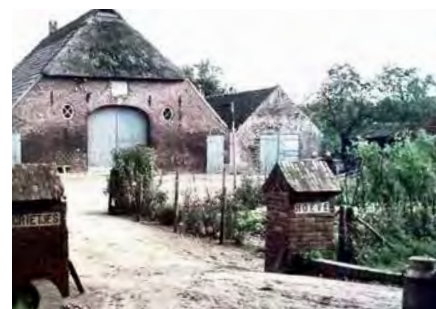
Boerderij De Grietjehoeve aan de Achterstraat moest wijken voor De Eikelhof.
