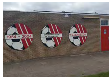
De in eigen beheer gebouwde kleedkamers.
