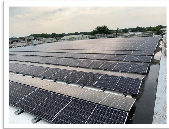
Project zonnepanelen: Aanleggen panelen op het dak van de nieuwe kleedkamers
