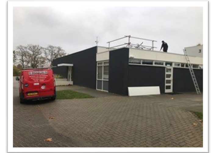
Vervangen dakbedekking
